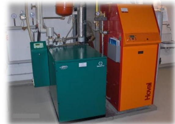
Blockheizkraftwerk
